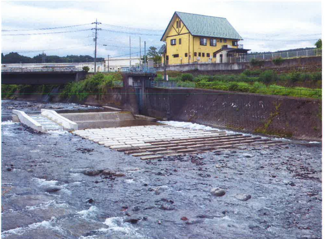
(富士宮市猫沢 安居山頭首工地区堰改修工事)
