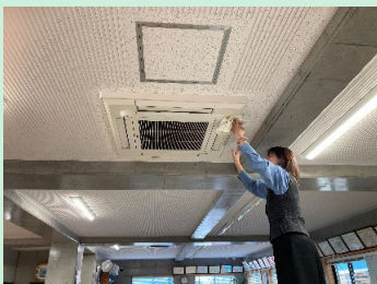
エアコンの清掃
