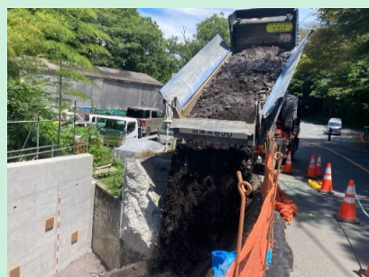
令和6年度 社会資本整備総合交付金事業2級市道西山安居山線改良工事において、建設発生土の有効利用
